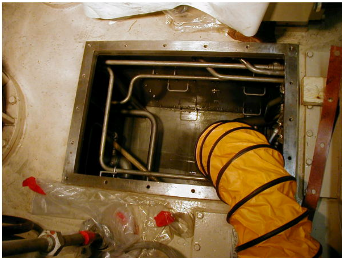
タンク内清掃作業現場
