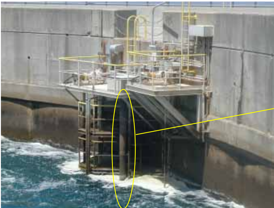
伊方1, 2号機放水口水モニタ設置状況
