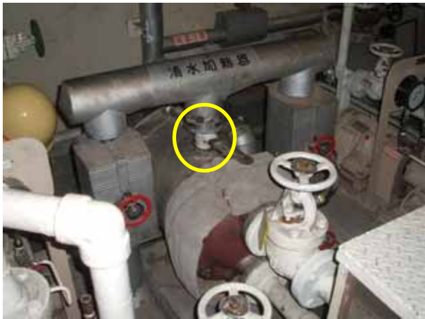
補修剤による応急措置
