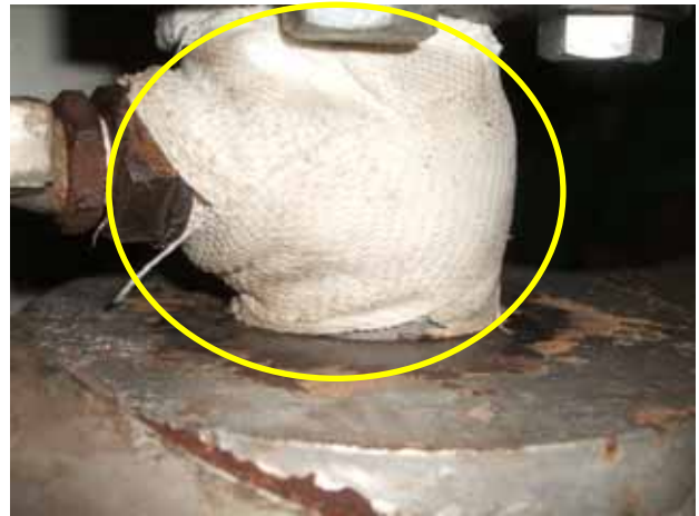
補修剤による応急措置
