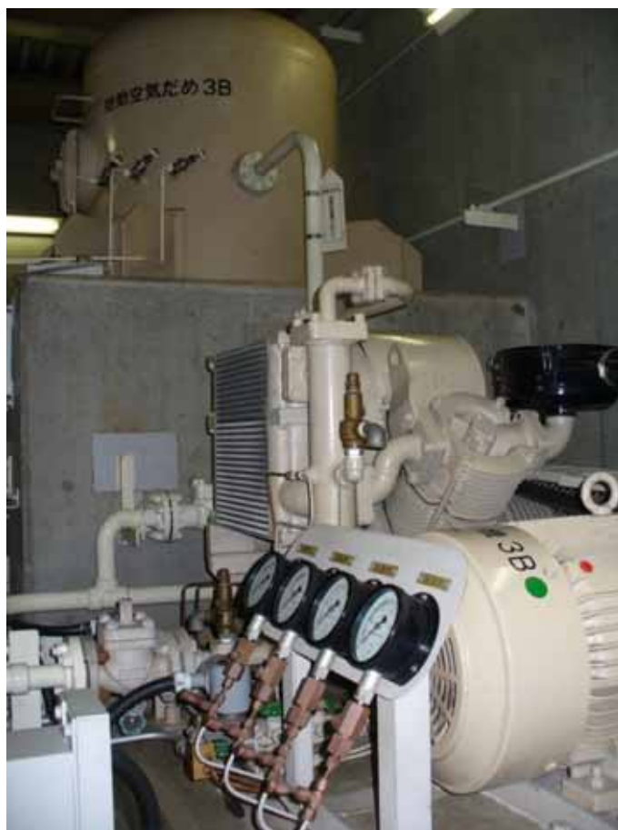
始動空気だめと始動用空気圧縮機
