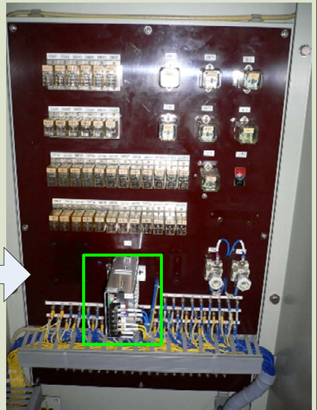
電源装置交換後
