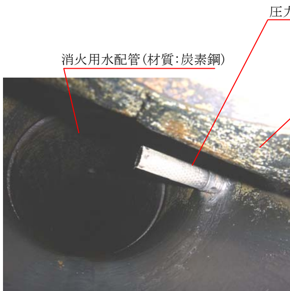
①減圧弁上流配管内部
