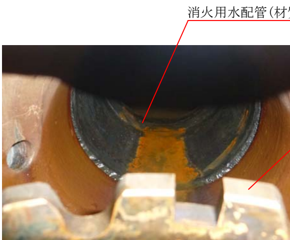
②減圧弁下流配管内部
