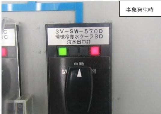
操作スイッチの緑ランプのみが点灯するべきところ、赤ランプ、緑ランプ両方が点灯している(完全に閉していない)
