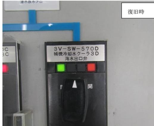
操作スイッチの緑ランプのみが点灯している(弁全開)
