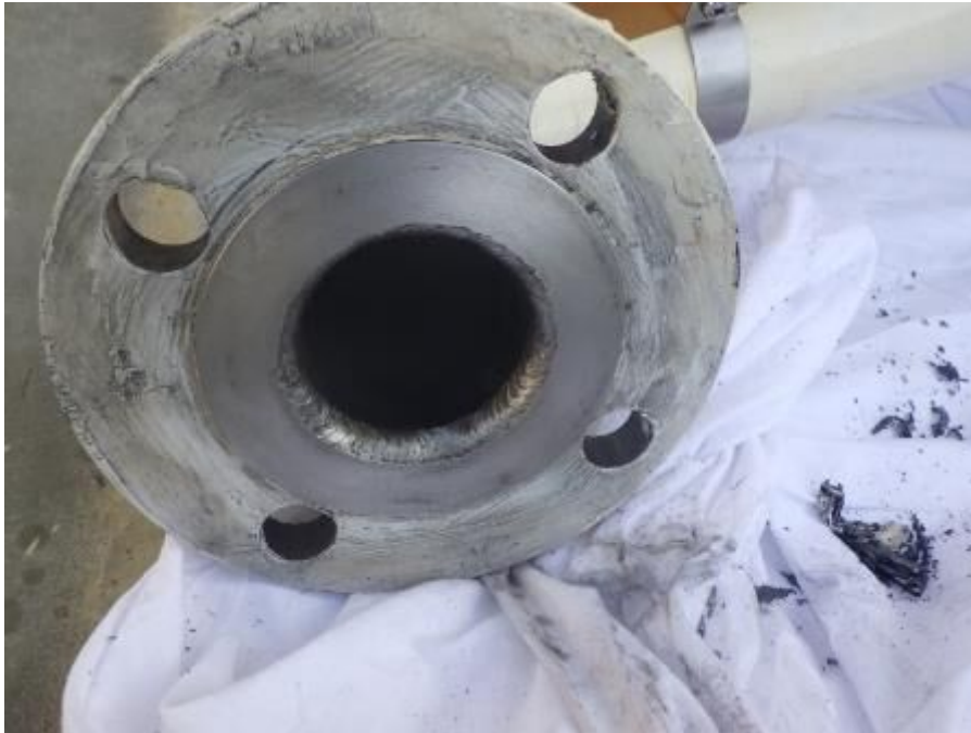
(上流側：貯油槽側フランジ)
