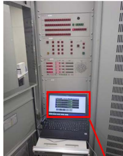
炉内核計装盤内部
