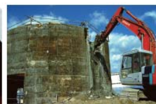
原子炉格納容器の解体
