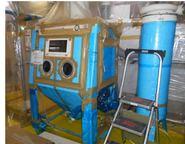
写真1 ブラスト除染を実施するためのグローブボックス
