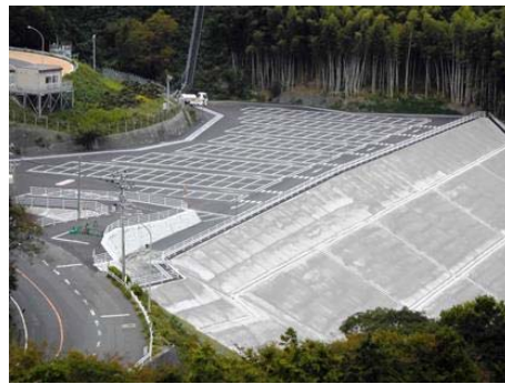
今回整備した発電所構内作業スペース [約7,000m 2 ]
