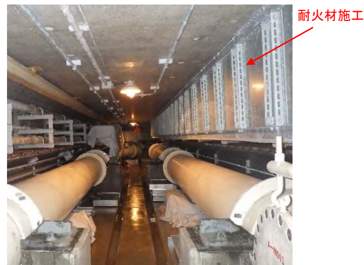
火災防護対策工事作業状況 (海水管トレンチエリア)
