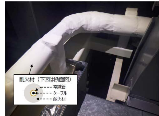
火災防護対策工事作業状況 (電線管への耐火材施工)
